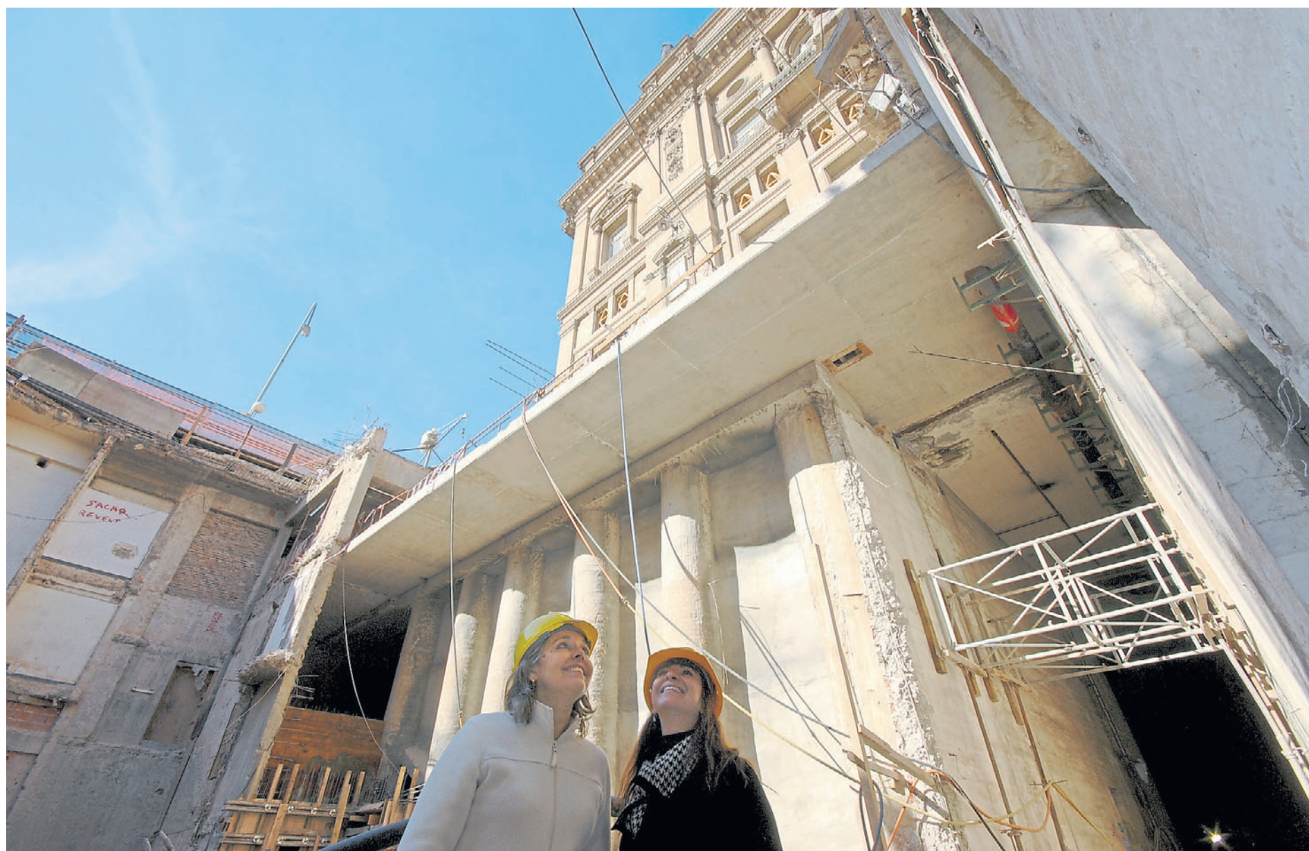
DESDE ADENTRO. La arquitecta Sonia Terrero durante las tareas de excavación y submuración lateral en el Teatro Colón.
